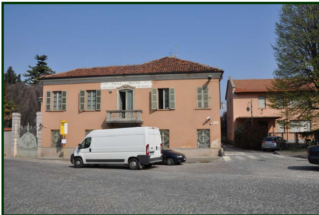
Foto 2. Prospetto principale su piazza San Bartolomeo
