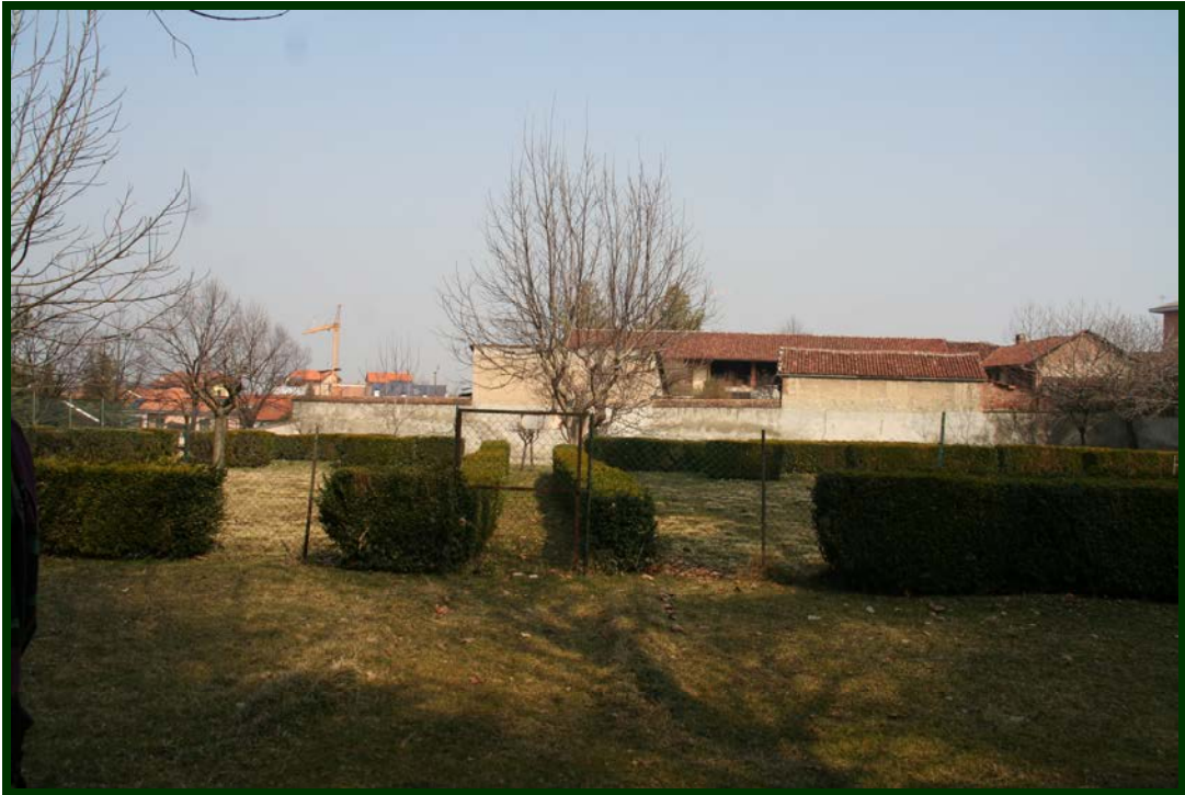
Foto 8. Muro di confine con orto antistante sul lato nord del lotto
