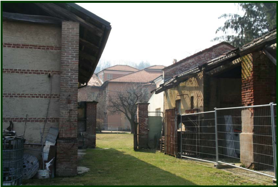
Foto 12. Bassi fabbricati pertinenti al lotto di proprietà
