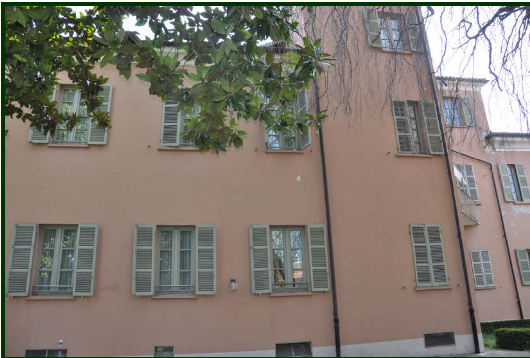
Foto 5. Prospetto ovest su cortile interno
