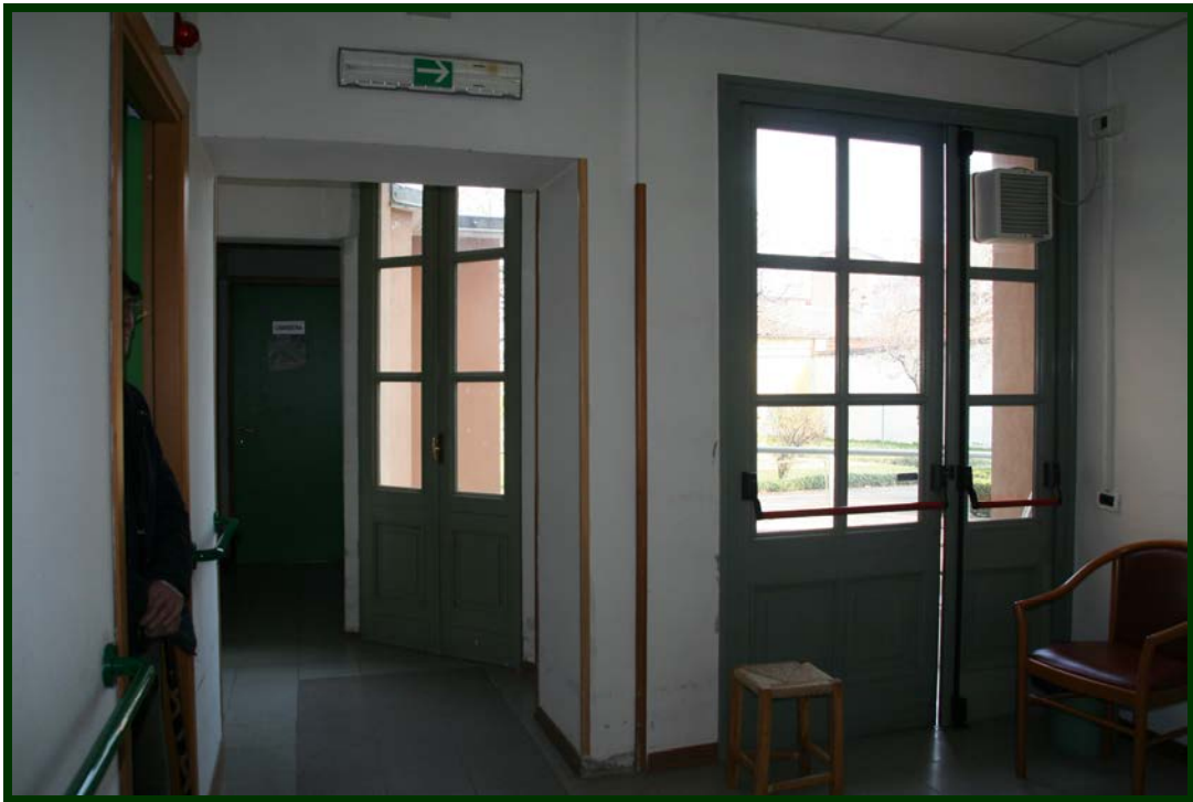
Foto 26. Corridoio camere piano terreno, uscita di sicurezza sul cortile nord
