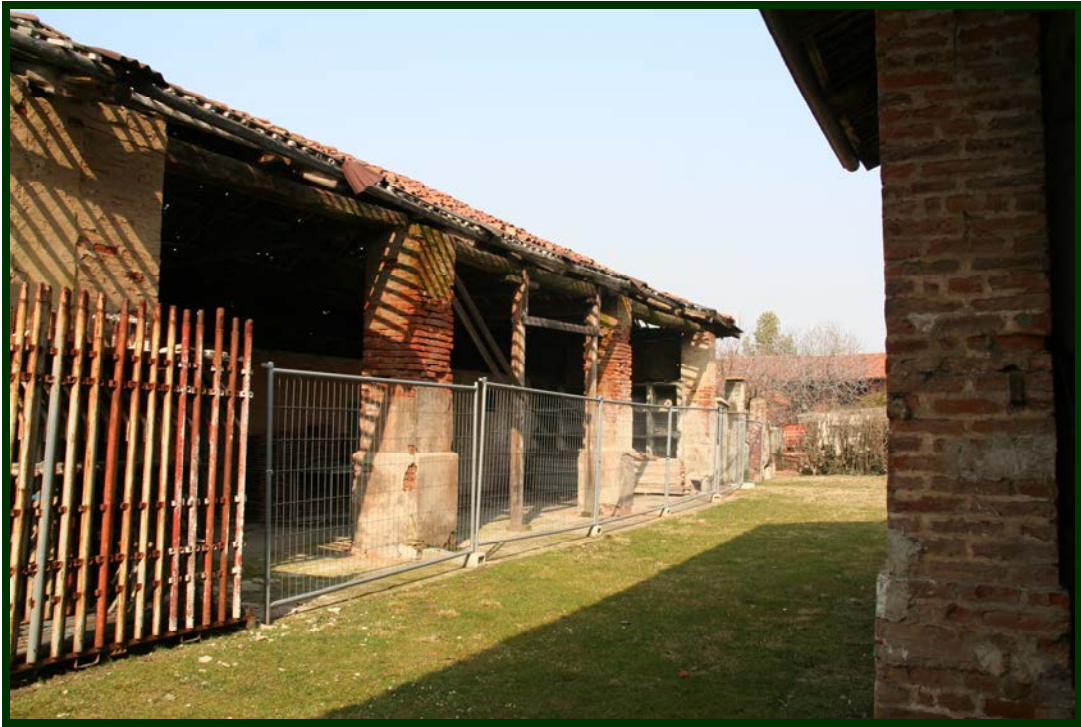
Foto 11. Bassi fabbricati pertinenti al lotto di proprietà
