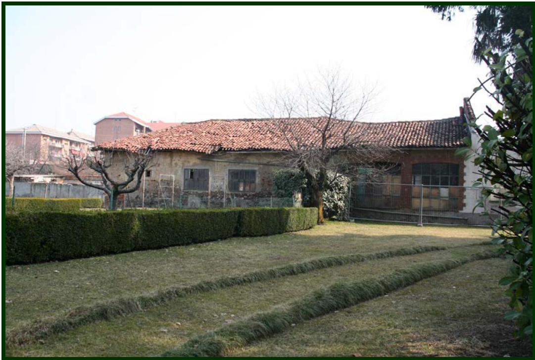
Foto 9. Bassi fabbricati pertinenti al lotto di proprietà. Prospetto ovest
