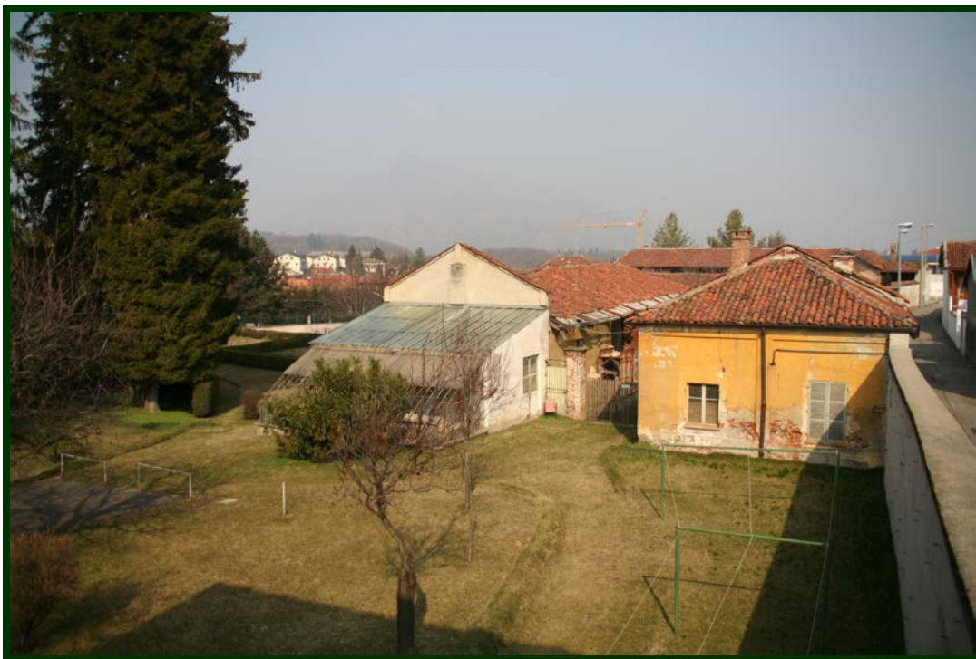
Foto 32. Vista nord: giardino, bassi fabbricati e via D'ala
