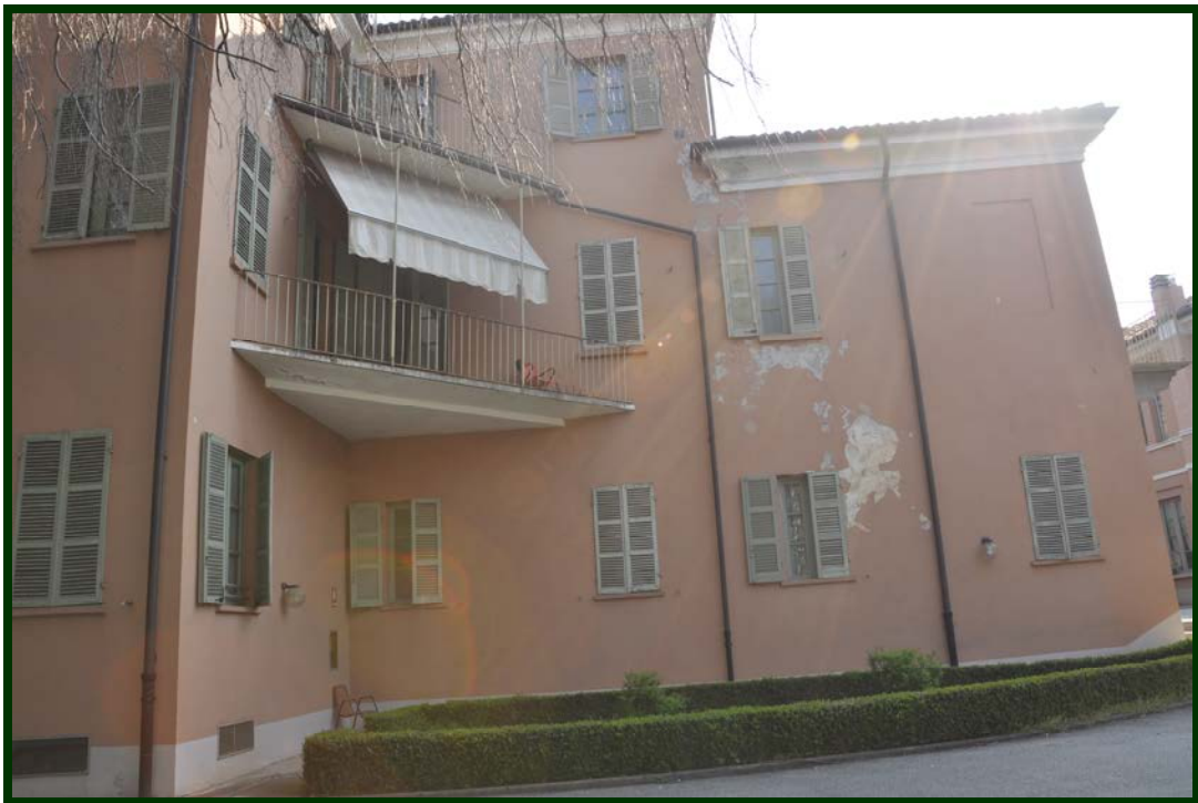
Foto 4. Prospetto ovest su cortile interno
